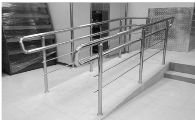
Рис. 25. Устройство пандуса
