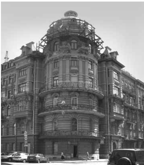
○ «Башня» Вячеслава Иванова (Доходный дом Дернова). Санкт-Петербург, Таврическая улица, дом 35
